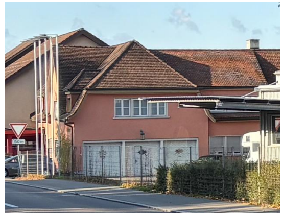
Bürogebäude (Assek-Nr. 120) | eigene Aufnahme (17.10.2025)
