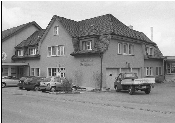
Bürogebäude (Assek-Nr. 120) | Hinweisinventar Bauten
